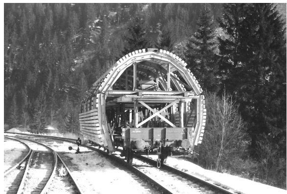
Abb. 7: Aufbau eines Leererüstes auf einem ÖBB-Waggon zum Betonieren des Gewölbes. Ein Blech als Schalhaut fehlt noch.
