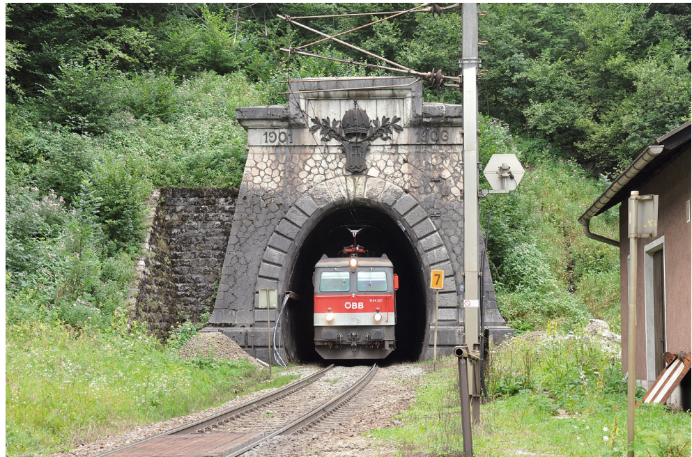
Abb. 8: Südportal. Schließlich erfolgte noch die Montage der speziellen Elemente: für die Aufhängung der Fahrleitung zum Beispiel oder für den Gleisbau. Am 29. Mai 1965 wurde die Strecke wiedereröffnet. Ab diesem Zeitpunkt führen Personenzüge durchgehend in Dieseltraktion, während bei Güterzügen in Spital am Pyhrn von Dampflok auf E-Lok beziehungsweise umgekehrt umgespannt werden musste.
