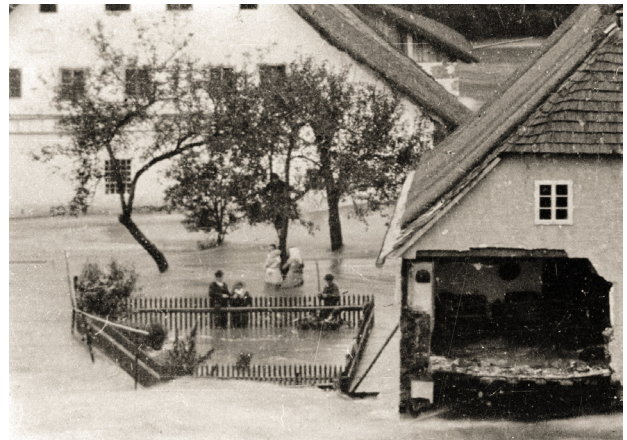
Abb. 2: Hochwasser der Feldaist in Pregarten, September 1888; im Jahr 1899 werden die Verhältnisse ähnlich gewesen sein.
