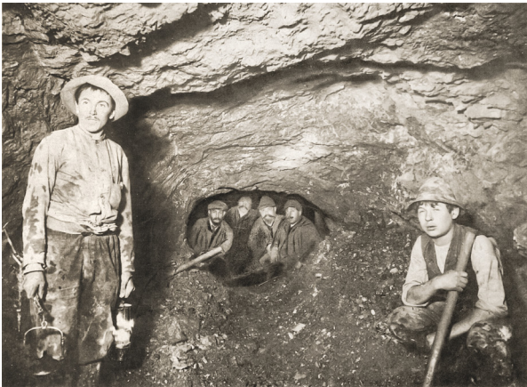
Abb. 4: Durchschlag. Kronen gelautet. Tatsächlich aber wurden insgesamt 9,426.400 Kronen verbraucht. Der Laufmeter Tunnelstrecke belief sich damit auf 1.980 Kronen. 13
