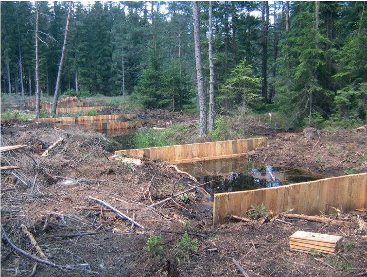
Abb. 2: Einbau der Sperranlagen.
